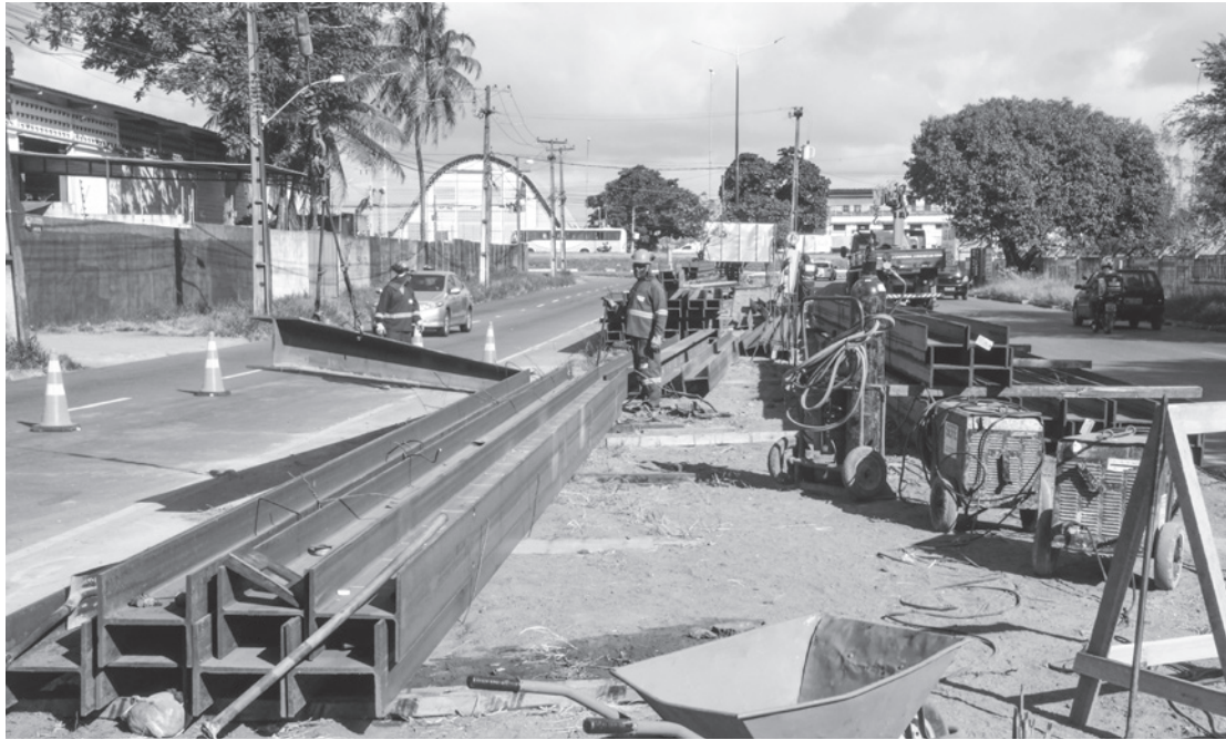
Novo viaduto da BR-101: começam as obras
